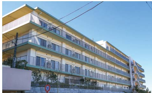
高台の上に建つ特別養護老人ホームラポール藤沢
